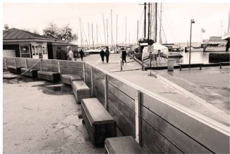
Reference: Mobilt system på Roskilde Havn monteret til stormflodsvarsel
