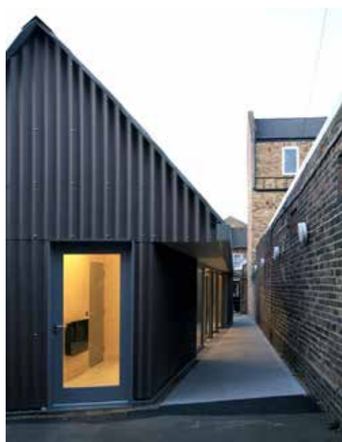
4. Byggeri med havneudtryk
