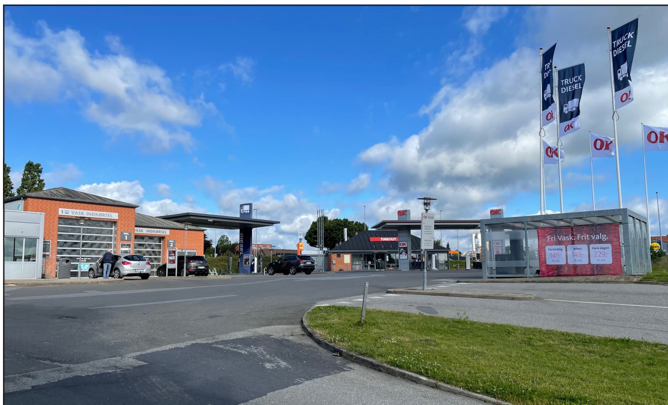
Lombjergevej 2A, hvor der i dag er tankanlæg, vaskehaller og grill.
